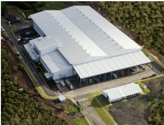
Centro de Operaciones “El Coyol”, Alajuela
