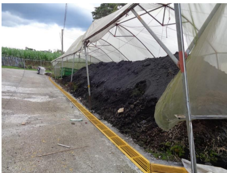
FIGURA 55. Construcción de ducto de drenaje para evitar el humedecimiento de materiales para la elaboración de substratos.
