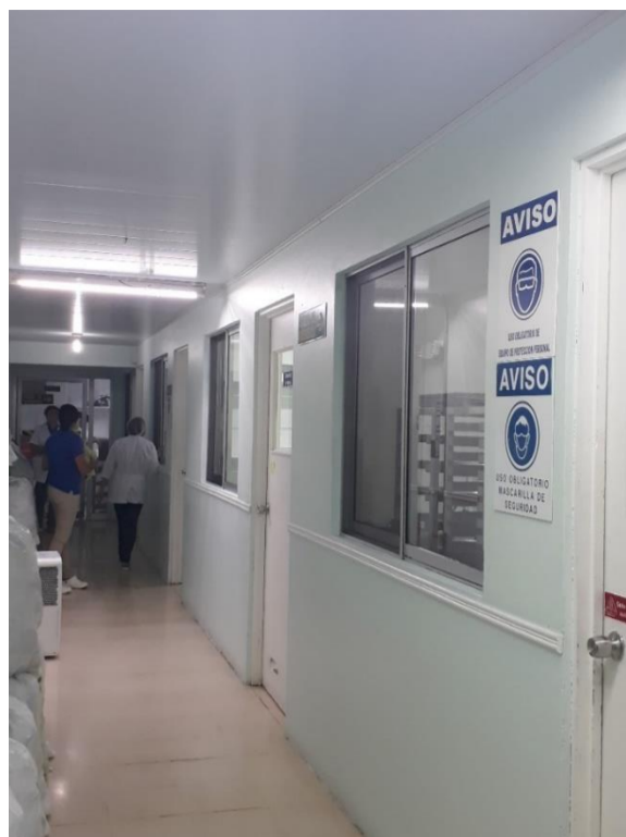
FIGURA 39. Cambio de cielorraso y ventanales.
