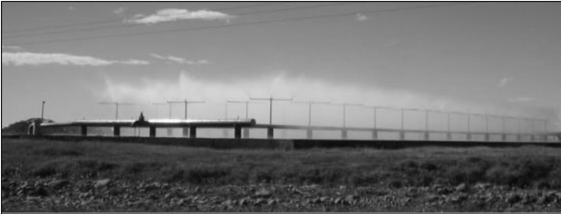
Foto #1. Sistema de enfriamiento de agua.
