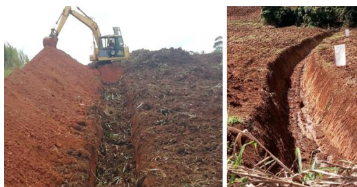
Figura 28. Construcción de drenajes para evacuar aguas.
