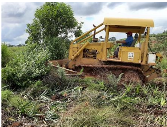
Figura 29. Limpieza y acondicionamiento del terreno.
