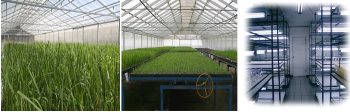
Figura 11. Invernaderos y laboratorios construidos y disponibles en DIECA.
