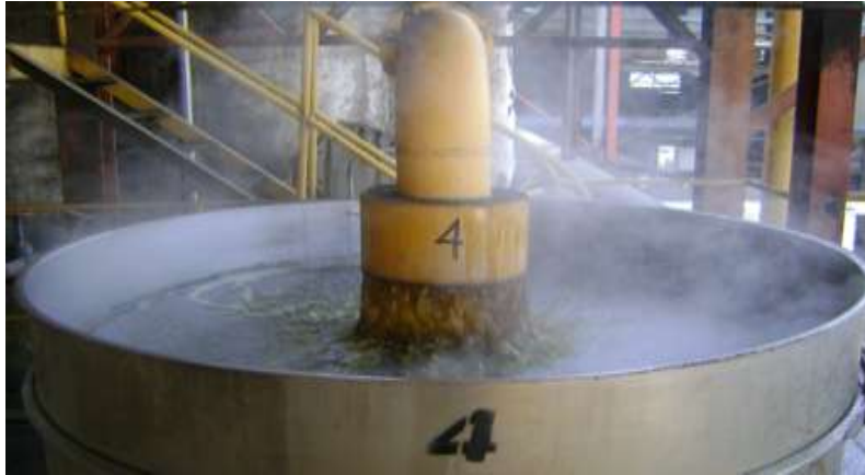
Operación de Filtros Eriez.
