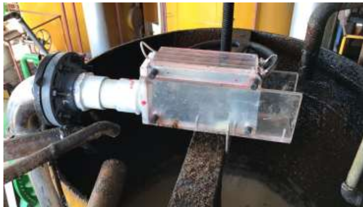
Figura 11. Prototipo de reactor de electrocoagulación instalado en la línea de Meladura B previo a la clarificación.
